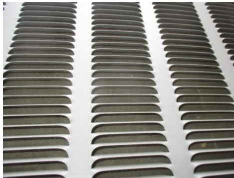
Dirty condenser fins
